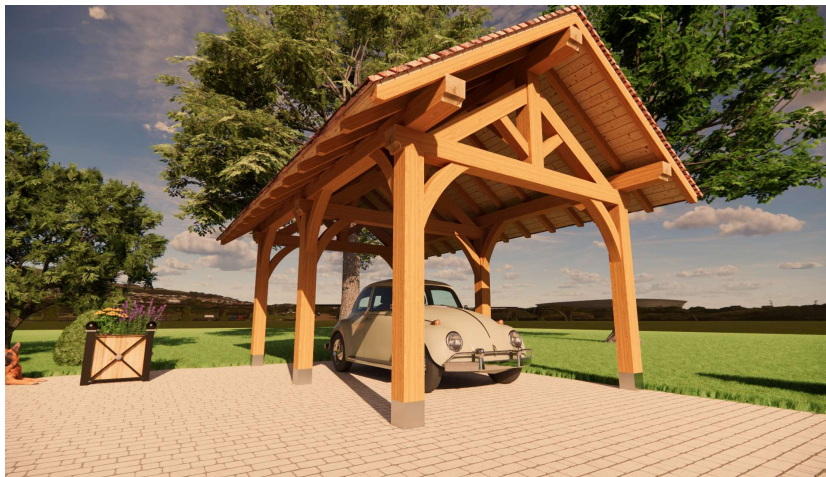
Charpente Pin Sylvestre Couverture tuile Lambris épicéa sur chevrons Bardage Douglas 20mm
