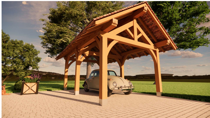
Charpente Pin Sylvestre Couverture tuile Lambris épicéa sur chevrons
